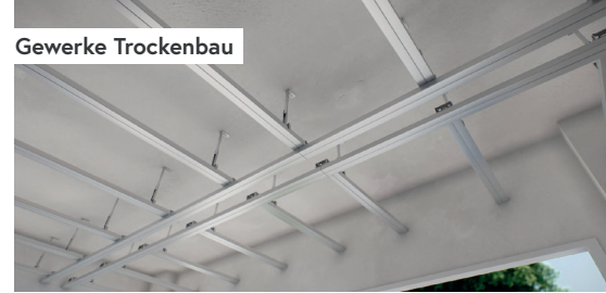
Schritt 3: Montage der Trockenbau Unterkonstruktion.
